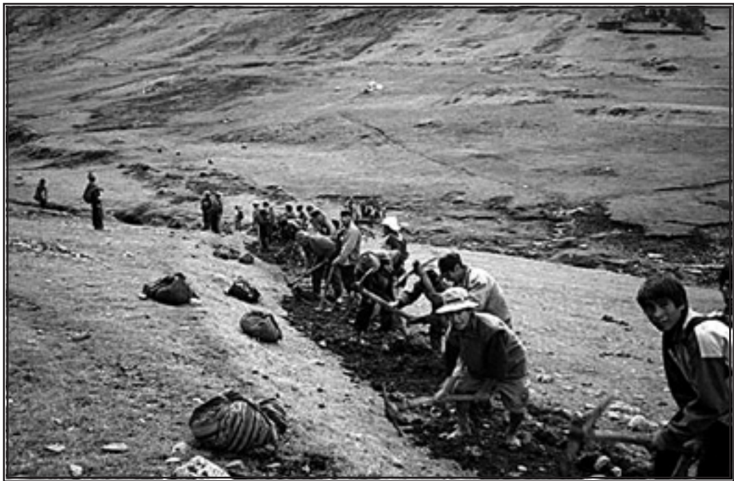
Arreglo de caminos, puentes y carreteras
