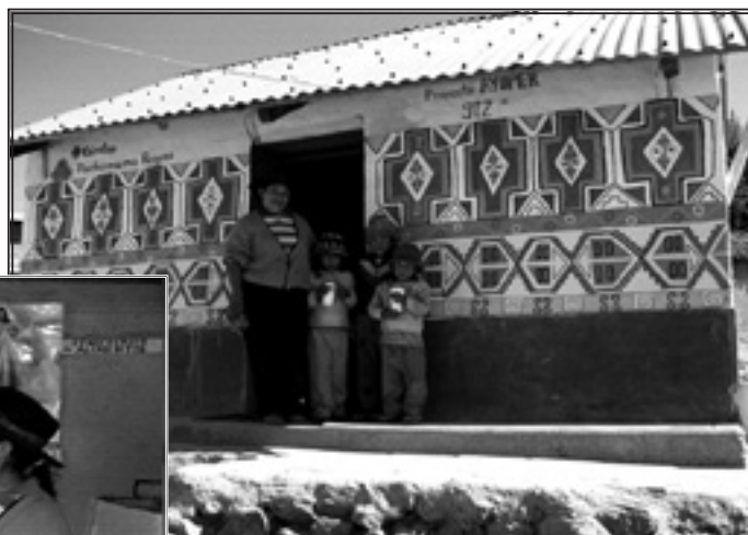
Decorado de la vivienda con pinturas naturales
