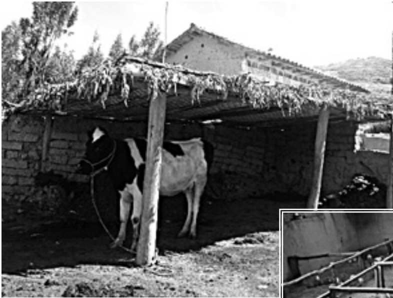
Construcción de Cobertizo para vacunos. Comunidad de Jullicunca - Ocongate
